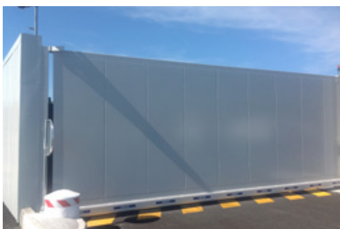
Portail avec tablier plein.
