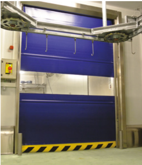
Porte avec système autoréparable.
